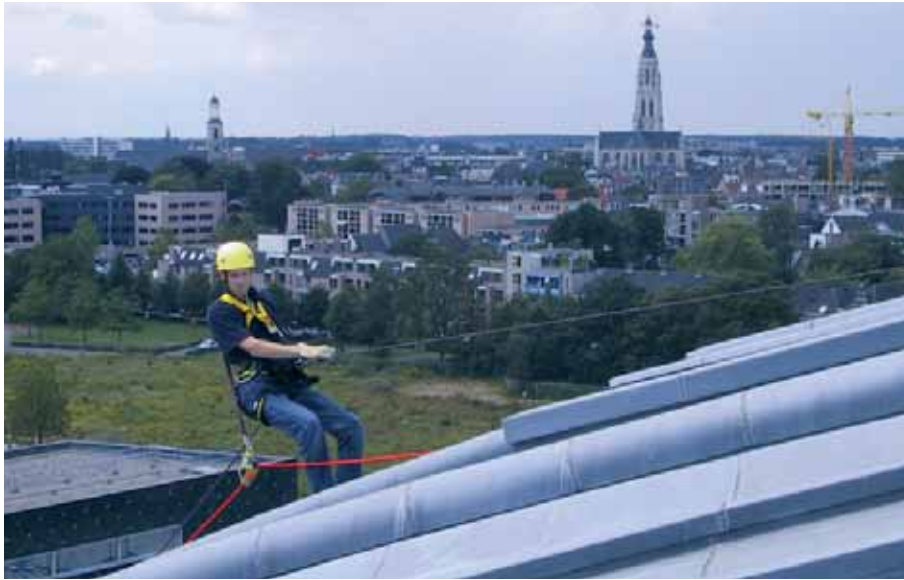
De Monumentenwacht doet onderzoek naar de bouwkundige staat van de Koepel
