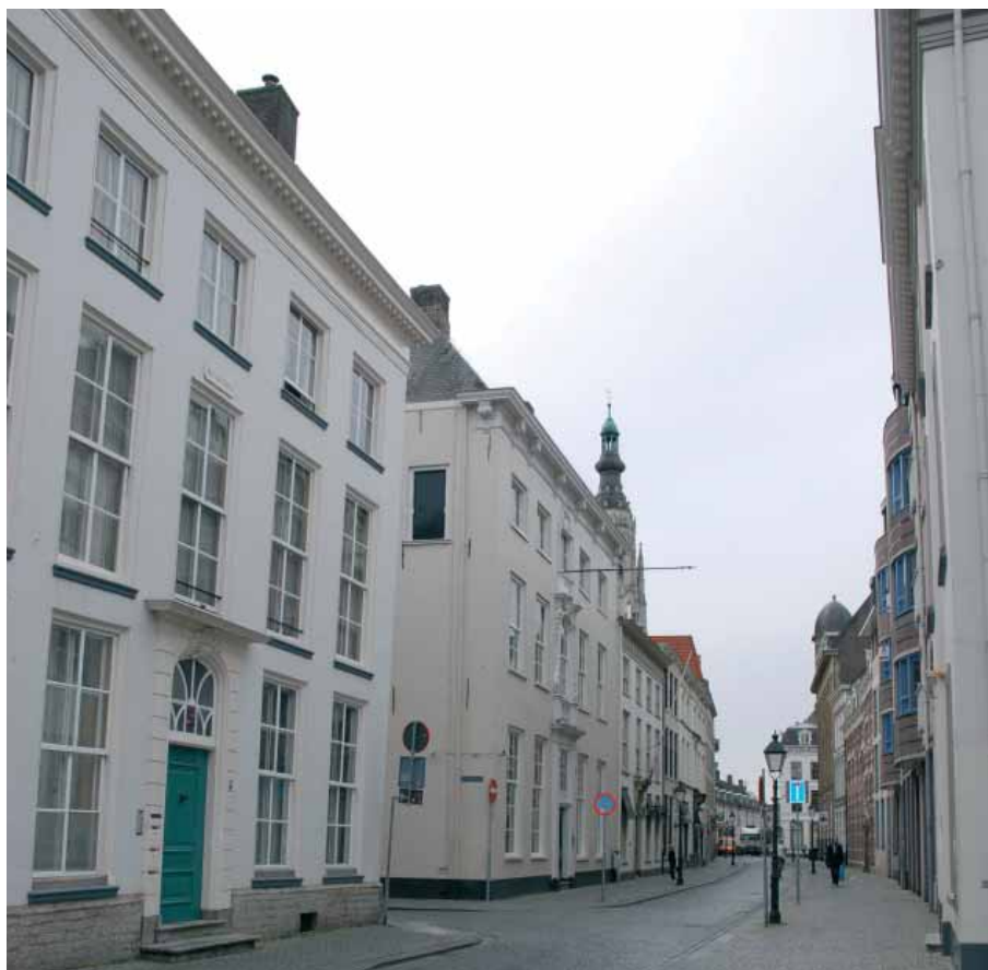
De panden aan de Catharinastraat vormen door architectuur en kleurgebruik een ensemble
